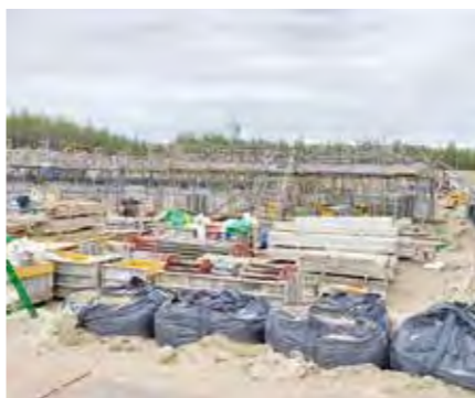
新クリーンセンター建設中の現場
