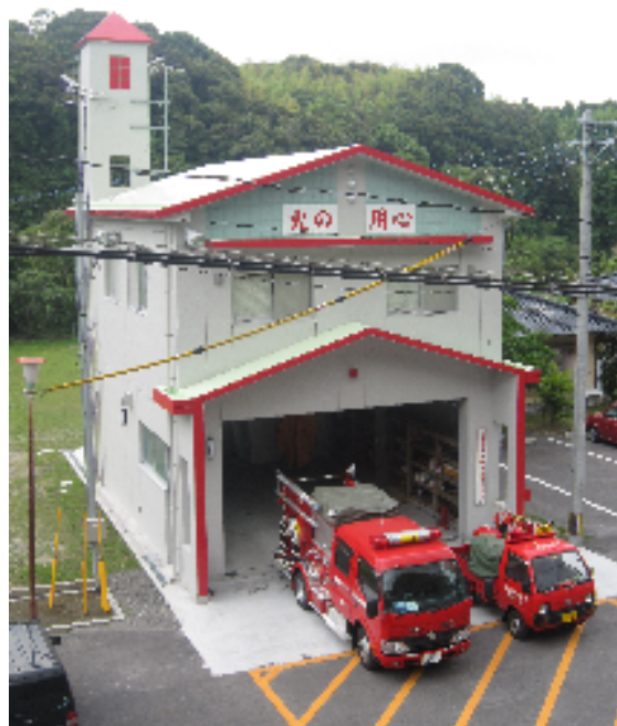
伊集院方面団土橋分団車庫（平成23年度末竣工）
