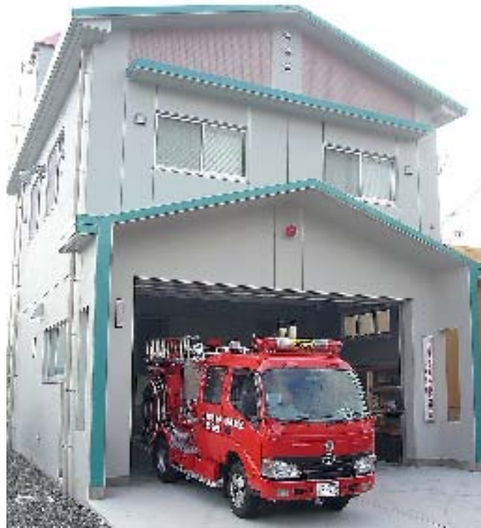
伊集院方面団中央東分団車庫（平成22年度末竣工）
