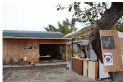
▲建設中の店舗兼住居（H27.11）
