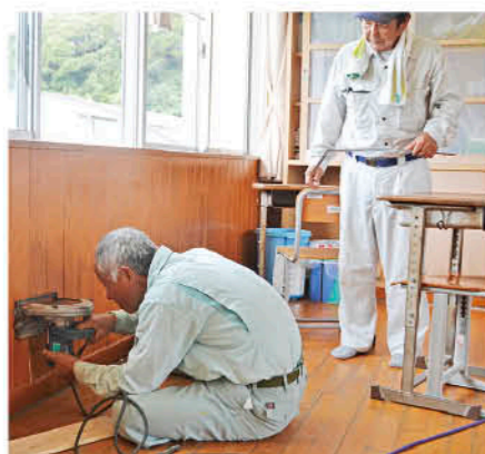
東市来中学校の教室の壁を補修する会員ら
