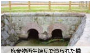
廃棄物再生煉瓦で造られた橋
