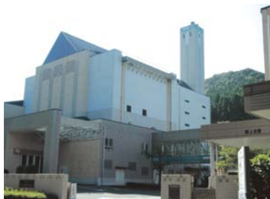
▲クリーンリサイクルセンター
