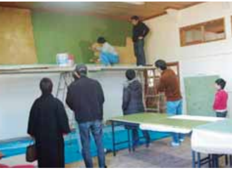
▲土壁塗りの実演中 (写真 ギャラリー野月舎)
