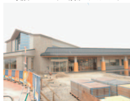
▲ 開館に向けて駐車場を整備中(外観)
