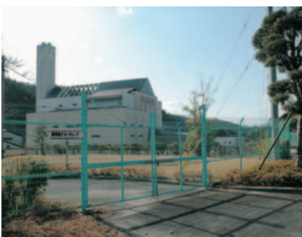
▲ クリーンリサイクルセンターの焼却施設
