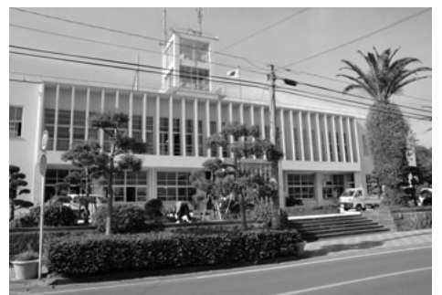
吹上支所庁舎
