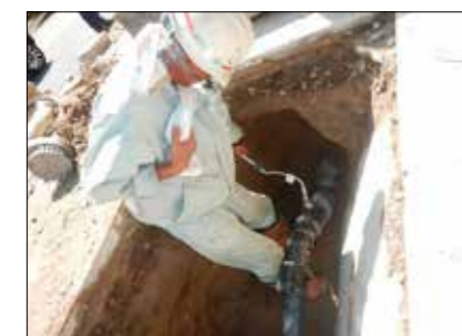
老朽化が著しい水道管を更新の様子
