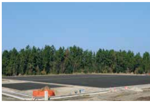
整備が進む吹上浜公園人工芝サッカー場
