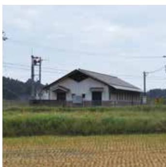
農業集落排水施設
