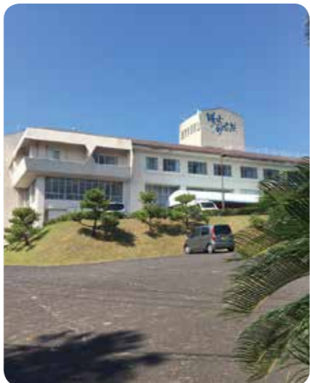
布設替工事を行う予定の吹上砂丘荘
