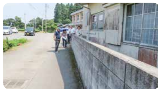
市内の小・中学校関係施設 全てのブロック塀を点検調査
