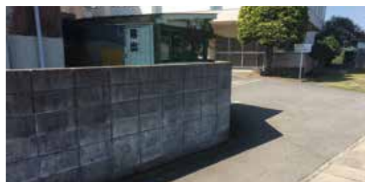
ブロック塀を撤去し、フェンスを設置
