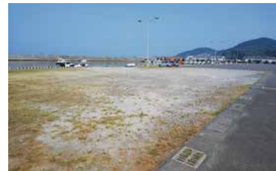
海砂のしゅんせつ・揚げ場・防波堤・用地 護岸等の整備
