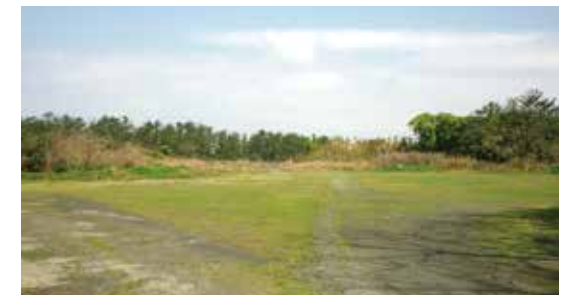
基礎・造成・トイレ・駐車場整備 (普通車約300台・バス約10台)
