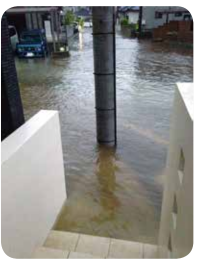
造成団地の道路の冠水写真
