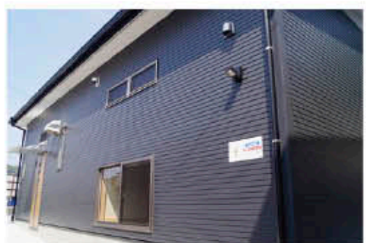
▲新しくなった窪田自治公民館
