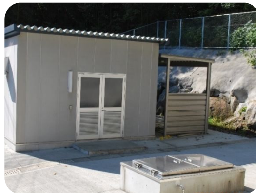
下養母水源地（深井戸 Q=800\text{m}^3/\text{日} ）
