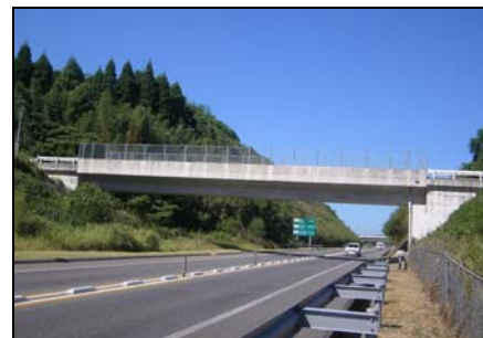
京之塚跨道橋
