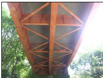
定期点検(1回 / 5年)
