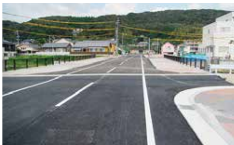
整備された湯之元橋(湯之元駅前)
