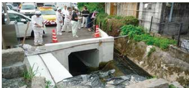
排水対策工事が進む山仁田川水路
