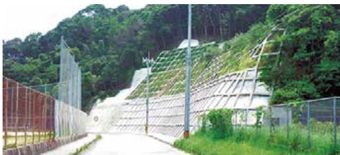
伊集院中学校～八久保住宅への市道愛宕山線法面修繕工事
