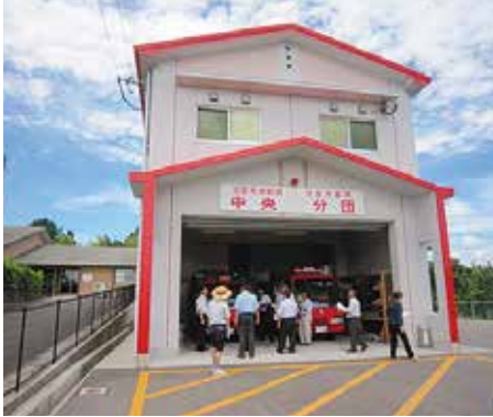
平成26年度に合併特例債を活用し完成した日吉方面団中央分団車庫
