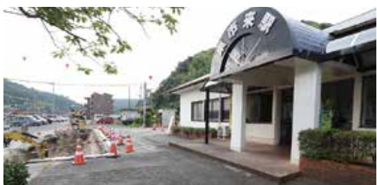
スロープ工事が進むJR東市来駅
