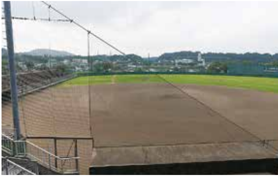
湯之元球場の防球ネット・スコアボード改修
