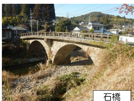
▲荻前田橋（1931年竣工）
