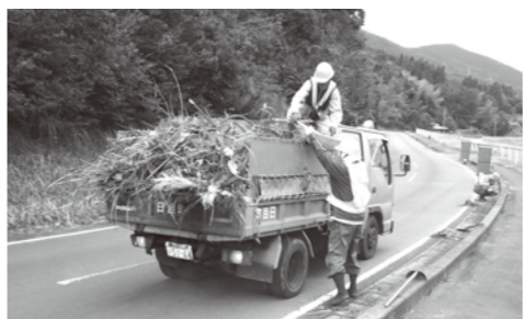
作業員の確保が難しい道路作業班
