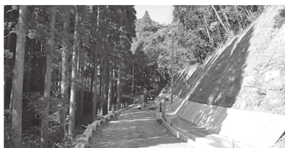
整備中の林道
