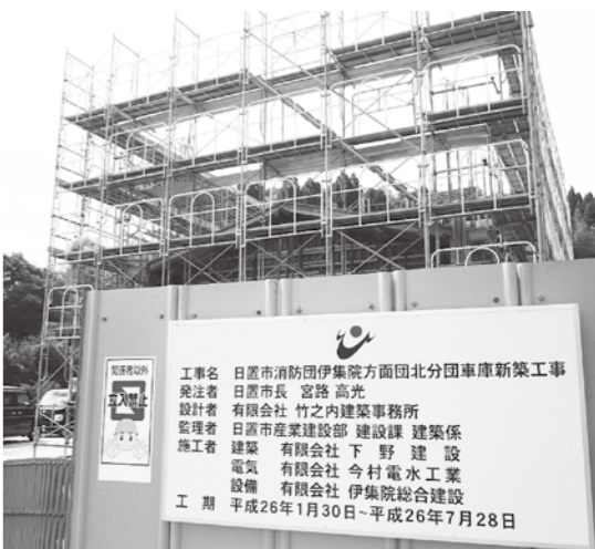
合併特例債を活用して建設中の伊集院北分団消防車庫
