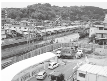
整備が進む伊集院駅北側
