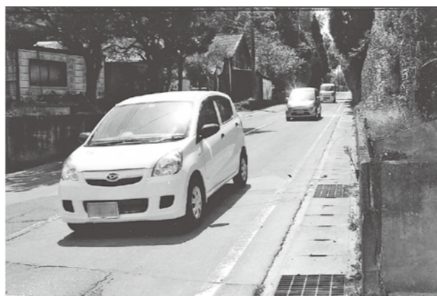
歩道のない郡中央通り線
