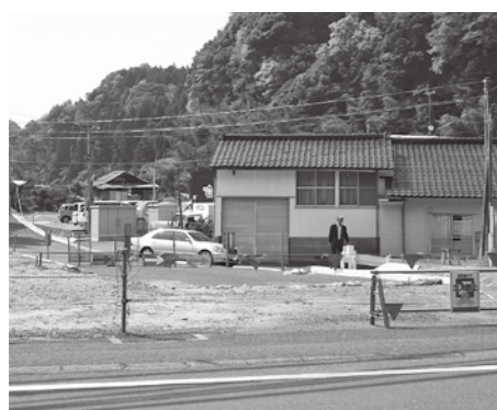
中川線の国道3号線交差点改良箇所
