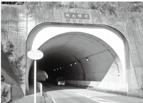
城山トンネル（隧道）
