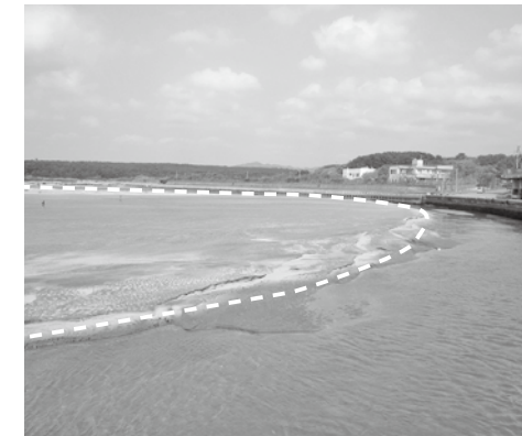
川幅の半分以上砂が堆積した吹上漁港
