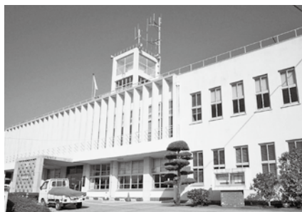
老朽化している吹上支所庁舎
