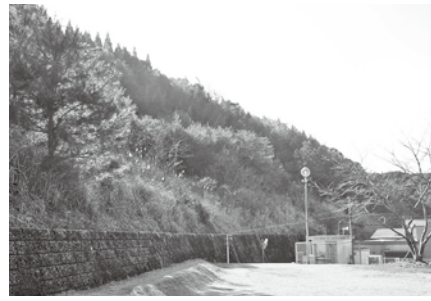
つつじヶ丘の急傾斜地
