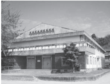
解体される吹上中央公民館の体育館
