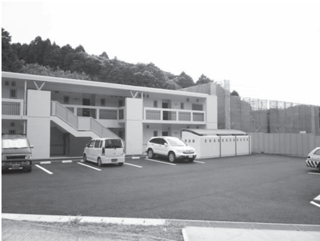
上市来の公営住宅（右側は建設途中）
