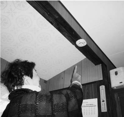
私も付けました。火災報知器
