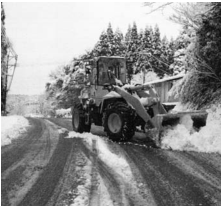
積雪・凍結に対応する作業風景
