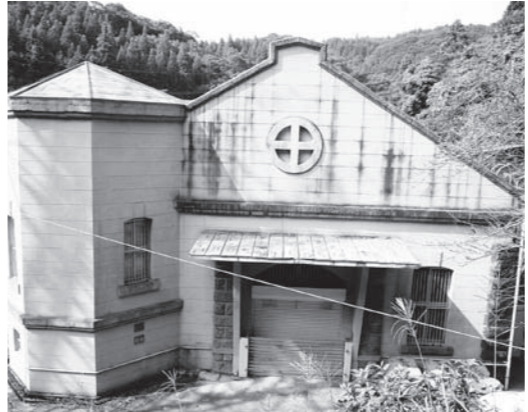
大田水力発電所（明治41年使用開始）
