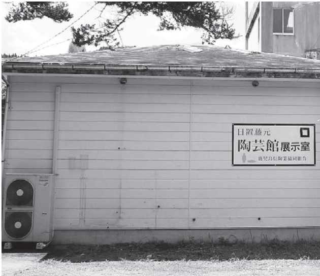
旧池田中学校跡地を利用している陶芸館
