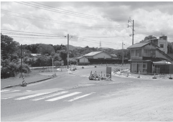
道路整備中のさつま湖公園入口付近
