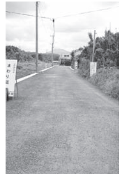
改良中の帆ノ港線
