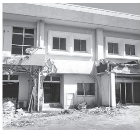
江口浜荘の解体工事
