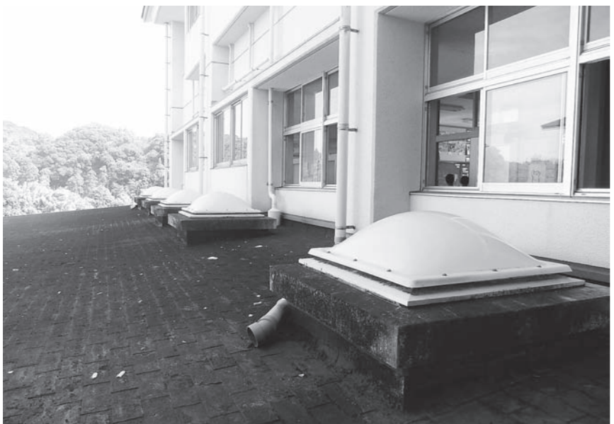
落下防止網を設置する花田小学校の天窓
