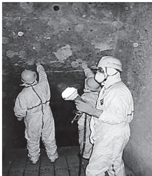
クリーン・リサイクルセンターの焼却炉の中を調査
