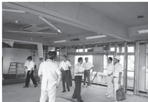
江口浜荘の解体現場を調査
