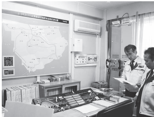
日吉支所の操作卓を調査
