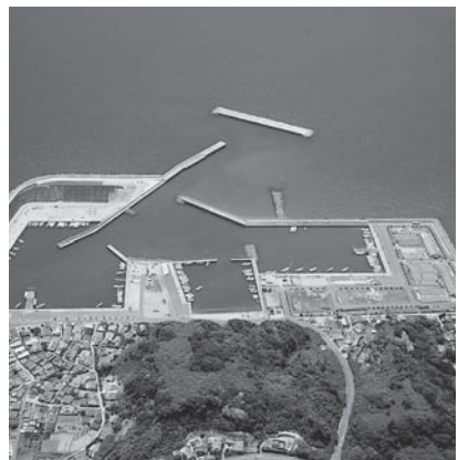
江口漁港の全景
