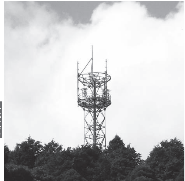
携帯電話の不 통화地域解消のために設置された鉄塔
