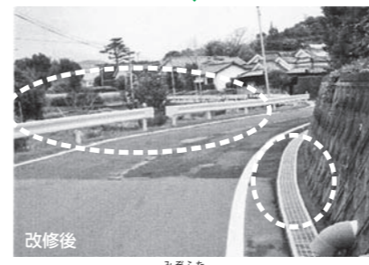
ガードレールと溝蓋の設置 (日新地区)
