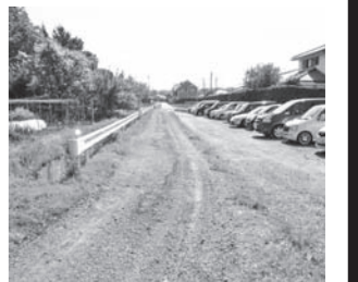
改修される冷水集落道(吉利地区)
