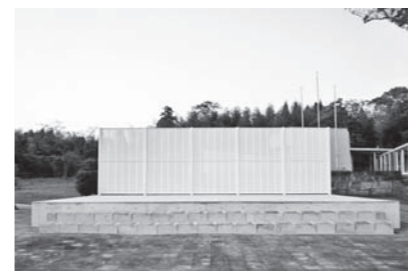
改修された東郷記念館野外ステージ (美山地区)
