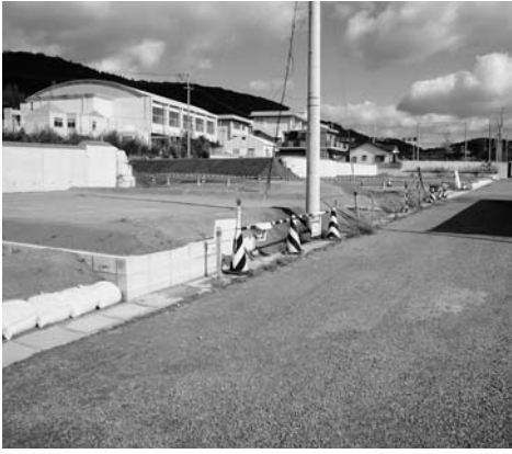
土地区画整理事業が進む湯之元第1地区 (向湯田)
