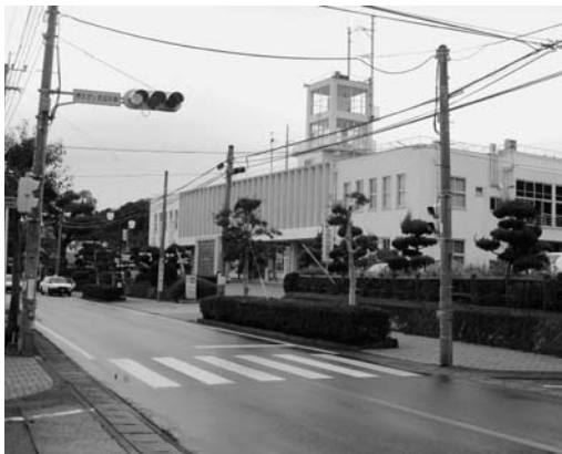
商店街の中心に位置する吹上支所の外観
