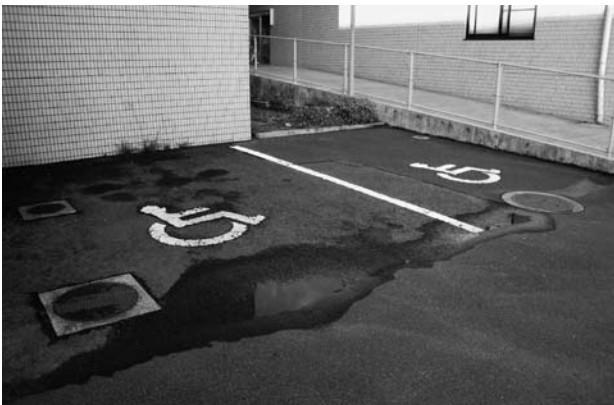
日置市中央公民館の障害者駐車場
