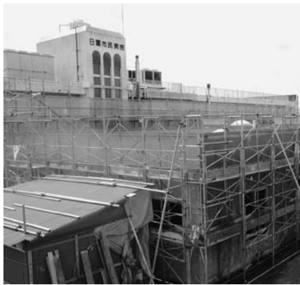
現在建設中の日置診療所
