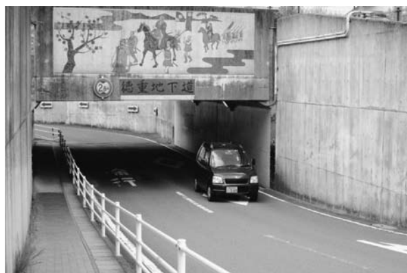
冠水警報システムが設置される徳重地下道（伊集院）
