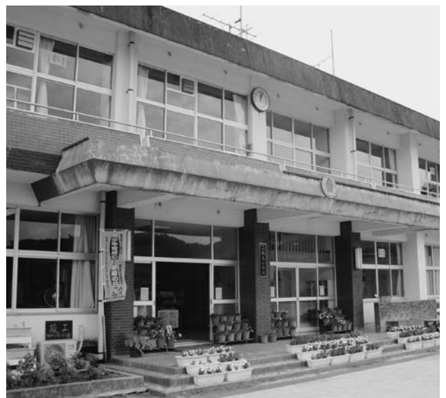
外壁改修が行われる鶴丸小（東市来）
