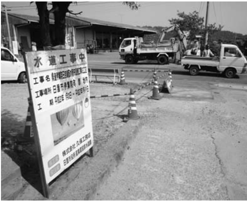
県道改良と同時に行われる水道管布設替工事
