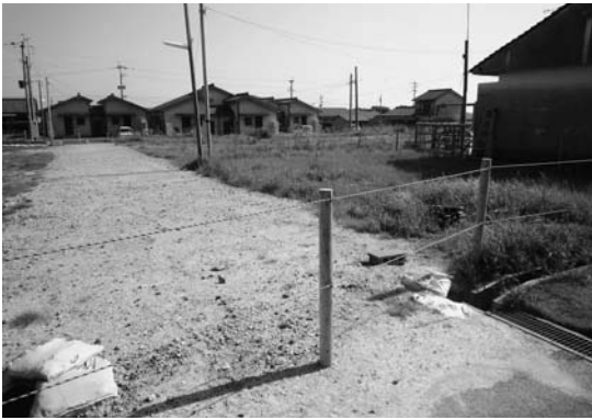
新たに建築される榎園住宅の敷地（日吉）
