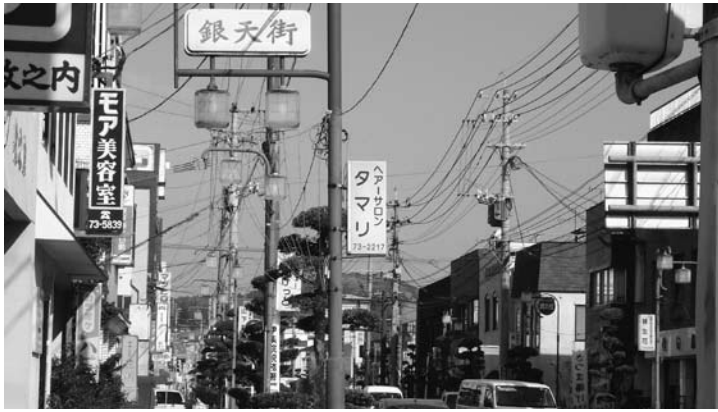
老朽化が進んでいる銀天街の街路灯（伊集院）
