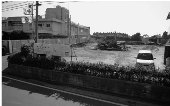
22年4月の開業に向けて工事が進む診療所予定地
