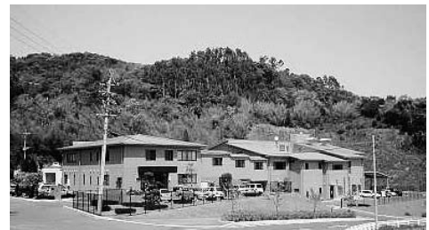
串木野衛生処理センター
