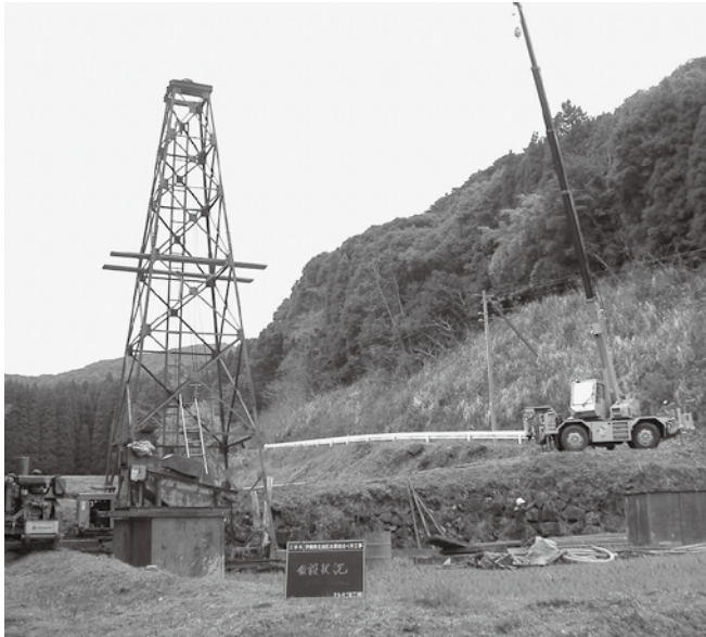
上神殿の水源地さく井工事
