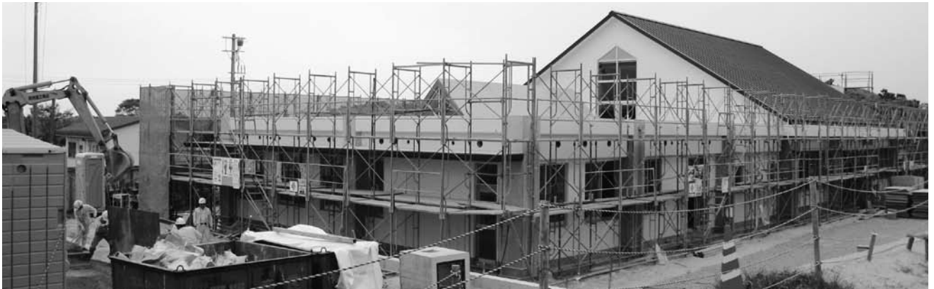
建設中の妙円寺地域交流センター
