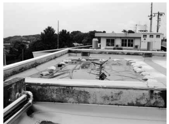
防水工事を行う日吉中央公民館屋上
