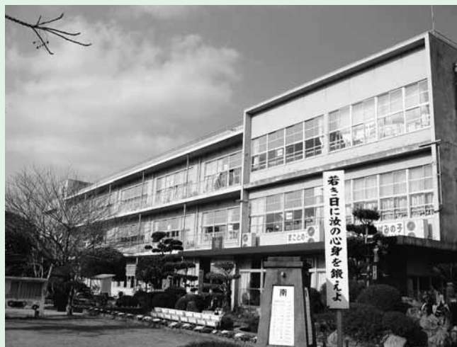
耐震診断を実施する伊集院小学校
