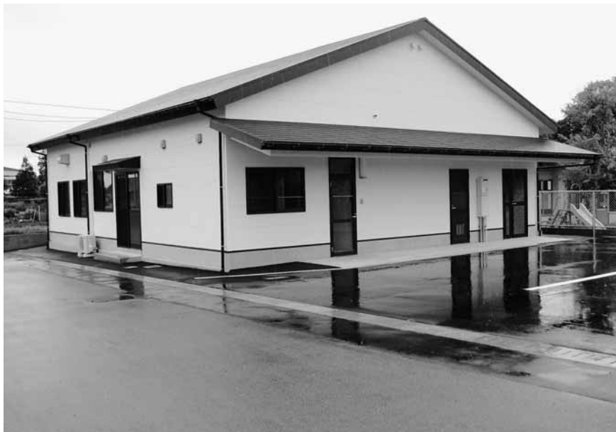
新たに建設された飯牟礼農産物加工センター（伊集院地域）
