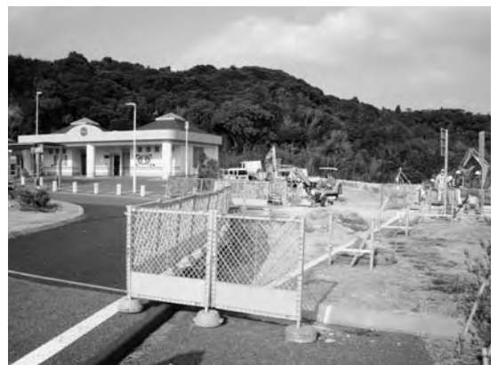
4月供用開始の美山IICの工事現場
