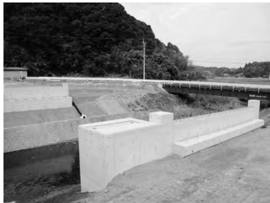
架け換え工事中の清藤橋（伊集院地域）
