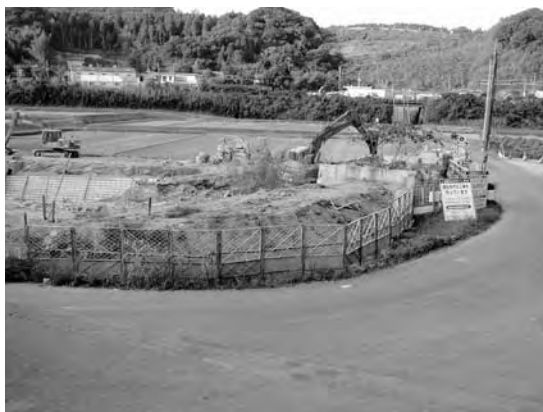
市道四郎園線の橋りょう工事 (伊集院)
