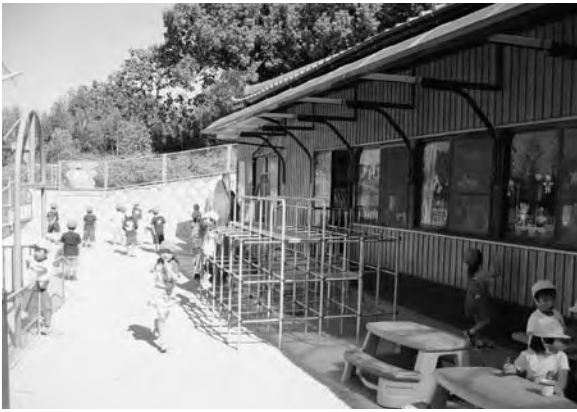
改築が予定される厳浄寺保育園（吹上）
