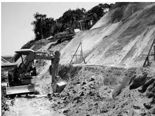
林地荒廃防止事業(吹上・堂園地区)
