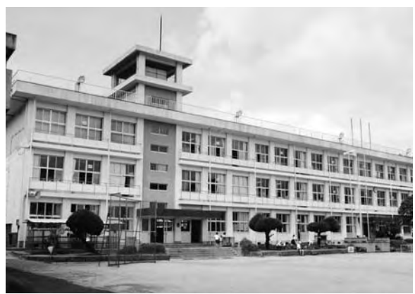
耐力度調査を行う 伊作小学校
