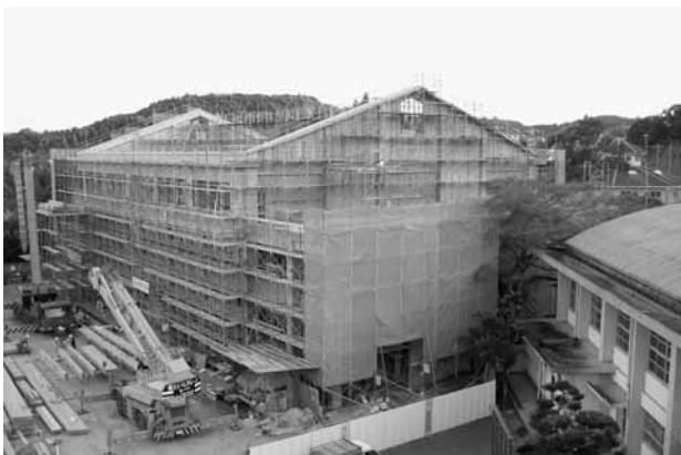
建築中の伊集院中屋内運動場
