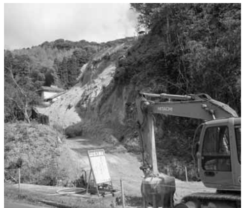
土砂災害から市民を守る治山工事（東市来地域）
