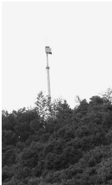
現況のテレビ 共同受信アンテナ (吹上地域)
