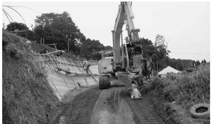
災害復旧工事中の現場(日吉地域)
