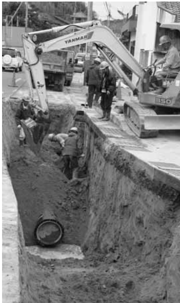
県営かんがい排水事業 導水管工事の様子
