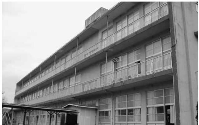
耐震化が急がれる老朽校舎(伊集院北小)
