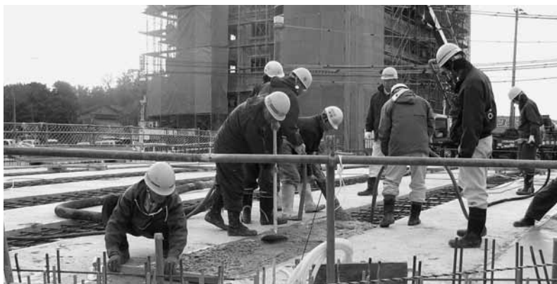
伊集院地域の濱川原橋の建設工事現場
